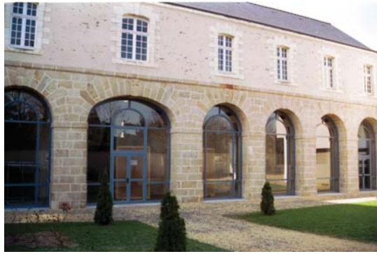
Le Vieux Couvent : granit taillé au rez-de-chaussée, encadrements des baies en tuffeau à l'étage
